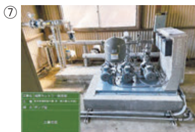
ポンプユニット更新
