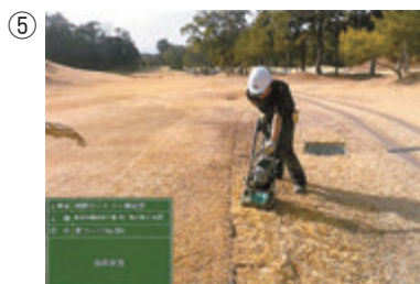
埋め戻し及び転圧作業
