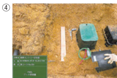
電磁弁・散水栓ボックス設置
