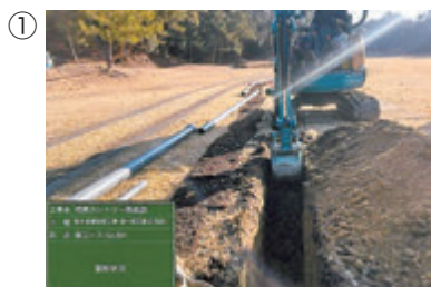
給水管敷設ルート掘削
