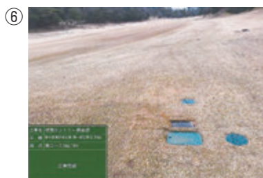
コース内工事完了
