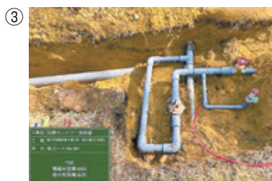
電磁弁、散水栓設置
